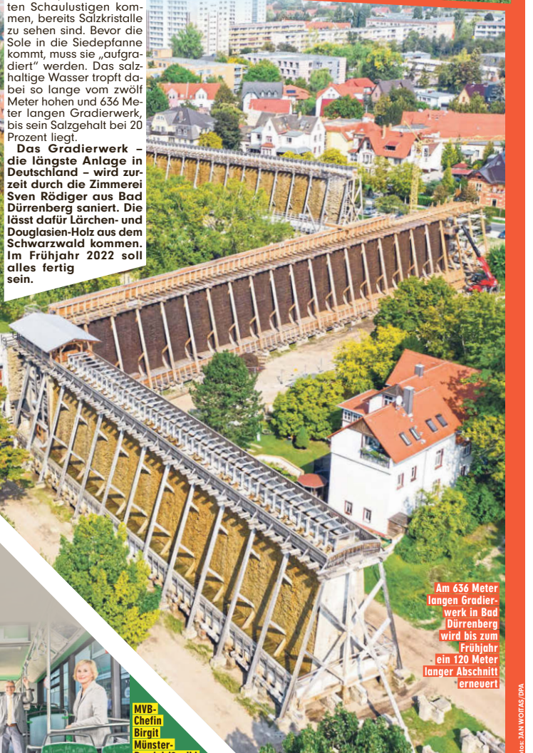
Arbeiter stopfen die fertiggestellten Abschnitte des Gradierwerks mit Schwarzdorn
